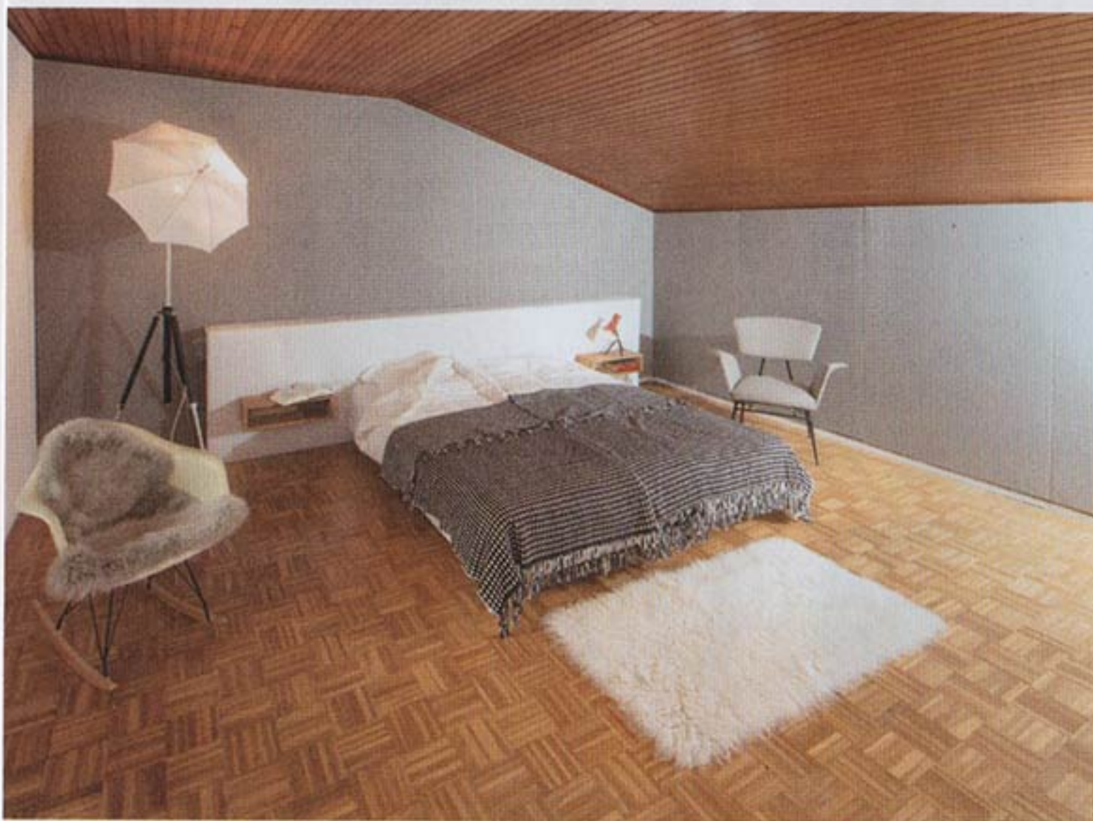
Ein Teil des Speichers war schon für Wohnzwecke ausgebaut gewesen. Geschliffen und mit Öl eingelassen, passt das alte Eichenparkett gut in den neuen Kontext.
