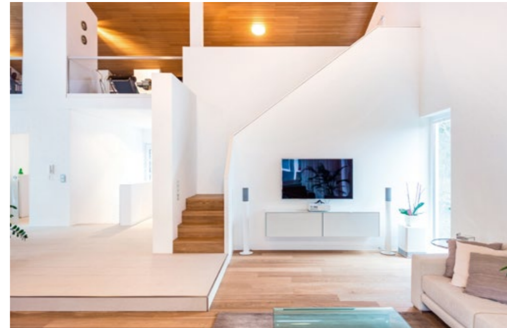
Unten und rechts: Die Treppe zur Empore wurde in den Wohnraum verlegt. Die jetzt massiv ausgeführte Brüstung schützt den Arbeitsbereich.
