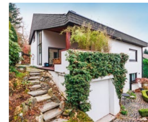
Von außen hat sich nicht viel verändert, das Gebäude wurde aber energetisch ertüchtigt. Japanisch angehaucht: der Garten.
