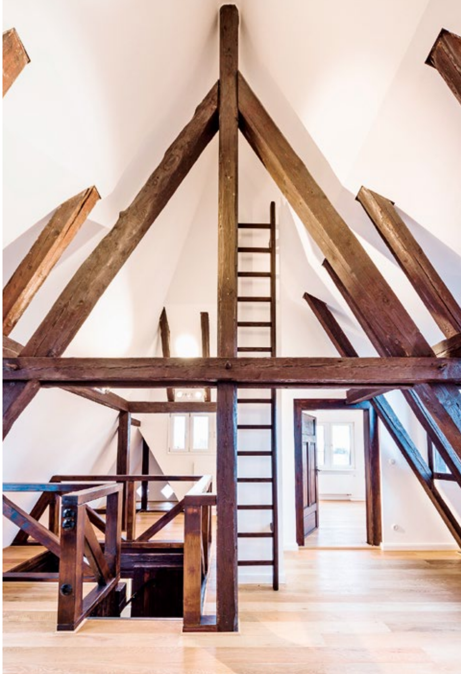
Der beeindruckende Dachstuhl bildet das (neo-)gotische Streben nach Höhe ab. Er überspannt eine sehr gut nutzbare Kubatur mit viel Raumqualität. Das neu eingebrachte Geländer rund um den Treppenabgang wurde optisch an die originalen Hölzer angepasst. Bodenbelag: helles Eichenparkett.
