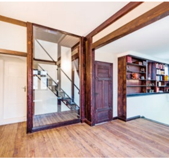
Durch Glas thermisch und akustisch entkoppelt: der Aufgang zum Dachgeschoss.
